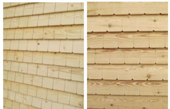
Aus feijährigem Holz, unbehandelt, vergraut nach und nach (links Fichte, rechts Lärche)
